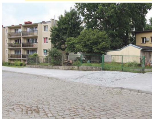
Zakończyły się prace przy przebudowie chodnika na ulicy Zakopiańskiej w Żarach.
