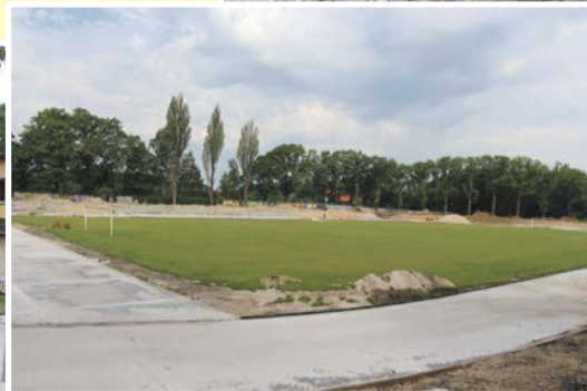
Trwają prace przy budowie stadionu lekkoatletycznego na Syrenie w Żarach. Na to zadanie dostaliśmy ok. 1,5 miliona złotych dofinansowania z Ministerstwa Sportu i Turystyki w ramach programu Rozwoju Infrastruktury Lekkoatletycznej.
