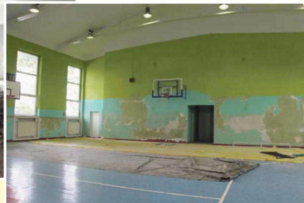
Hala sportowa „Promień” - trwa modernizacja oświetlenia, wentylacji z malowaniem hali, wykonanie nowej podłogi sportowej.
