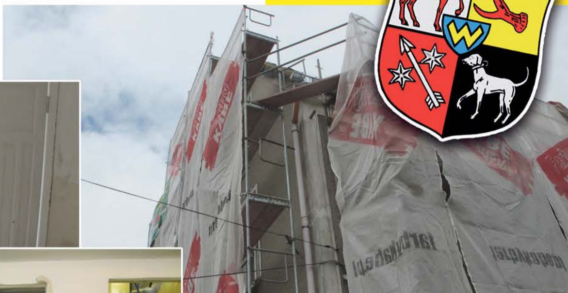
Miejskie Przedszkole Nr 3 - wymiana pokrycia dachowego.
