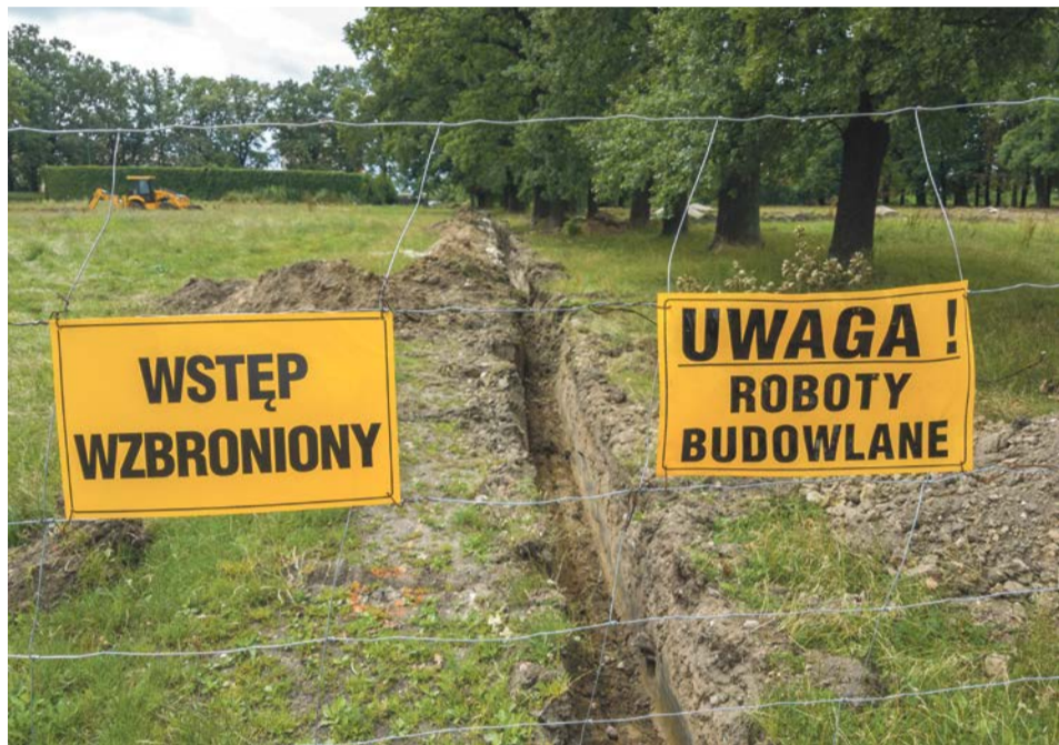
Prace na terenie parku już trwają fot. Andrzej Buczyński
