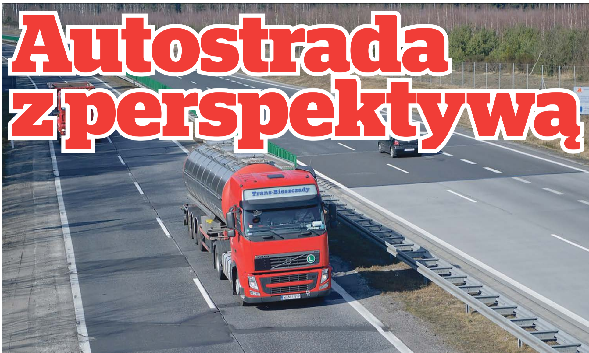
Południowa nitka „osiemnastki” jest nie tylko w fatalnym stanie technicznym. Jest wstydem wizerunkowym dla całej Polski. To pierwsza droga, na którą wjeżdżają goście i turyści z zachodniej Europy fot. ARMG
