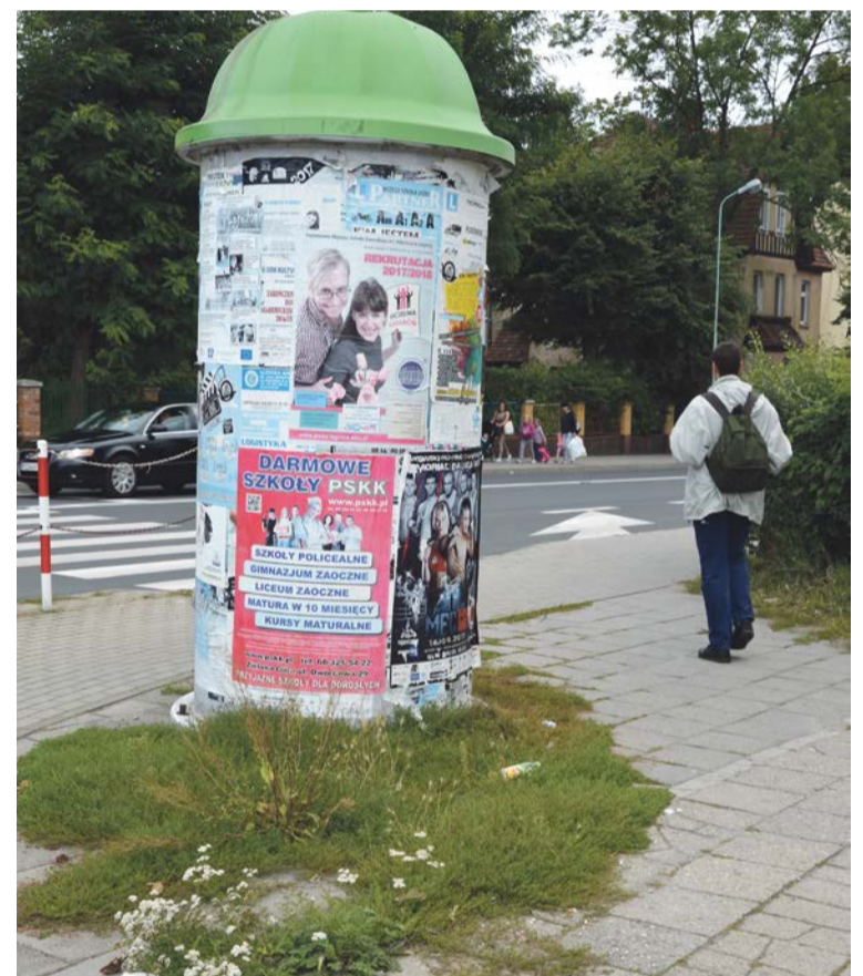
Pochylony słup ogłoszeniowy, zapadnięty chodnik, kępy trawy i śmieci fot. Halina Gola
