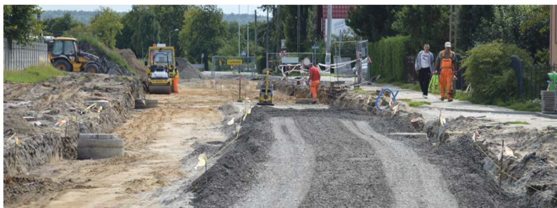
Budowlańcy systematycznie posuwają się z pracami od ronda Tadeusza Ślusarskiego w kierunku centrum fot. Halina Gola
