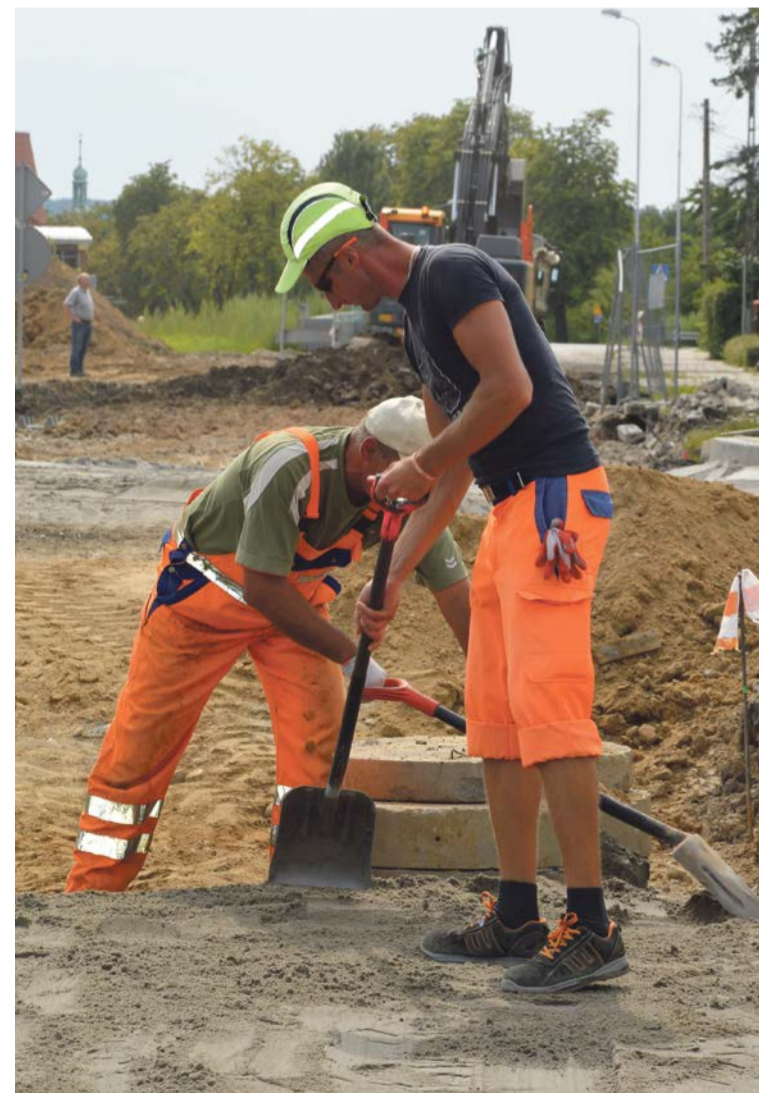
Trwają intensywne prace przy przygotowaniu podbudowy pod asfaltową nawierzchnię fot. Halina Gola
