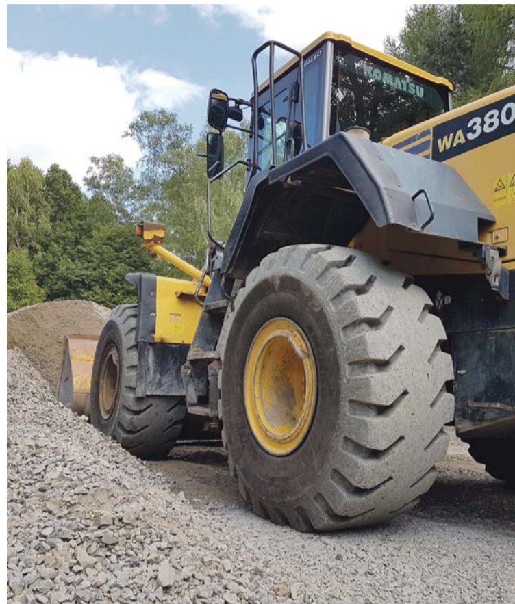
Hałda tłucznia będzie podłożem dla nowej drogi fot. Andrzej Buczyński
