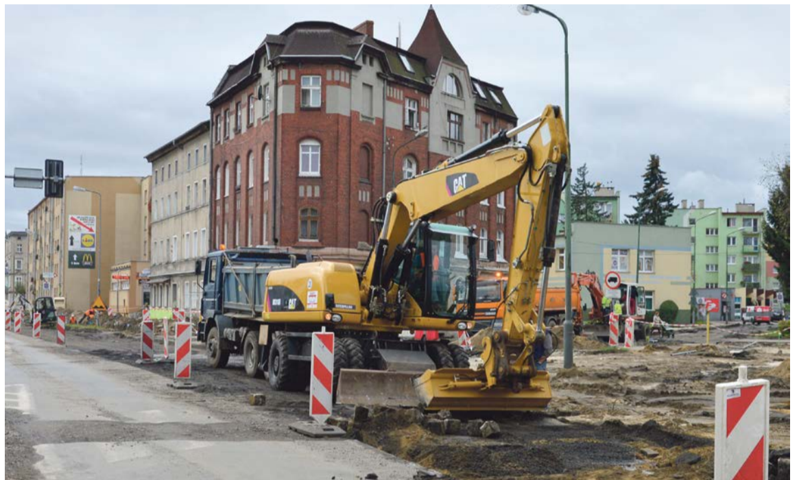
Trwają intensywne prace budowlane fot. Halina Gola
