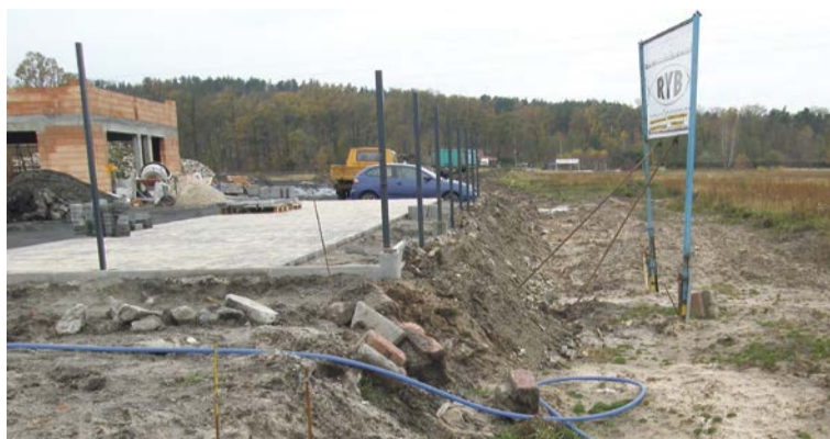
Dotychczasowa droga, do której jest zjazd z obwodnicy, biegnie pomiędzy budynkiem a ogrodzeniem - w prywatnej działce Mariusza Wrony. Droga gminna, która nie jest faktycznie wybudowana, biegnie równolegle do granicy ogrodzenia. Budowniczy obwodnicy zrobili błąd. Zjazd wykonali kilka metrów dalej, w drogę prywatną, zamiast w drogę gminną fot. Halina Gola
