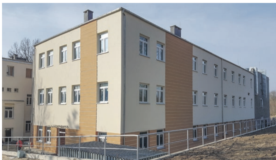
Nowy obiekt szpitalny wymaga jeszcze wykończenia wewnątrz fot.Andrzej Buczyński
