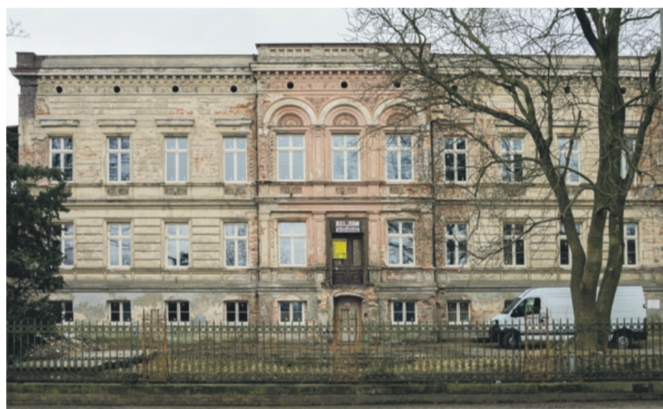
Willa Frenzla przy pl. Inwalidów jest sukcesywnie remontowana fot.Halina Gola
