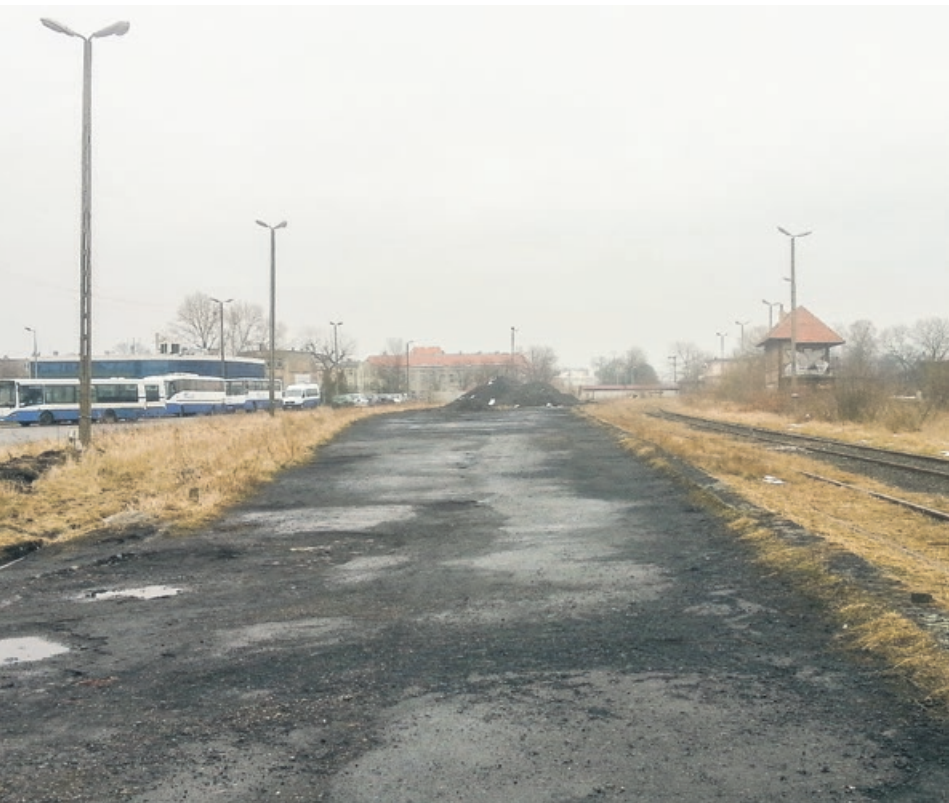
Na torami miała powstać kładka dla pieszych i rowerów. Kładka miała połączyć dwie części miasta, ul. Tunelową i Okrzei z ul. Przeładunkową. Budowa rozbija się o brak możliwości pozyskania dofinansowania na ten cel. Miasto próbowało już dwukrotnie pozyskać pieniądze. Spełnienie warunków dofinansowania okazało się niemożliwe, ze względu na zbyt krótki okres czasu, w którym miasto musiałoby zbudować kładkę fot.Paweł Skrzypczyński
