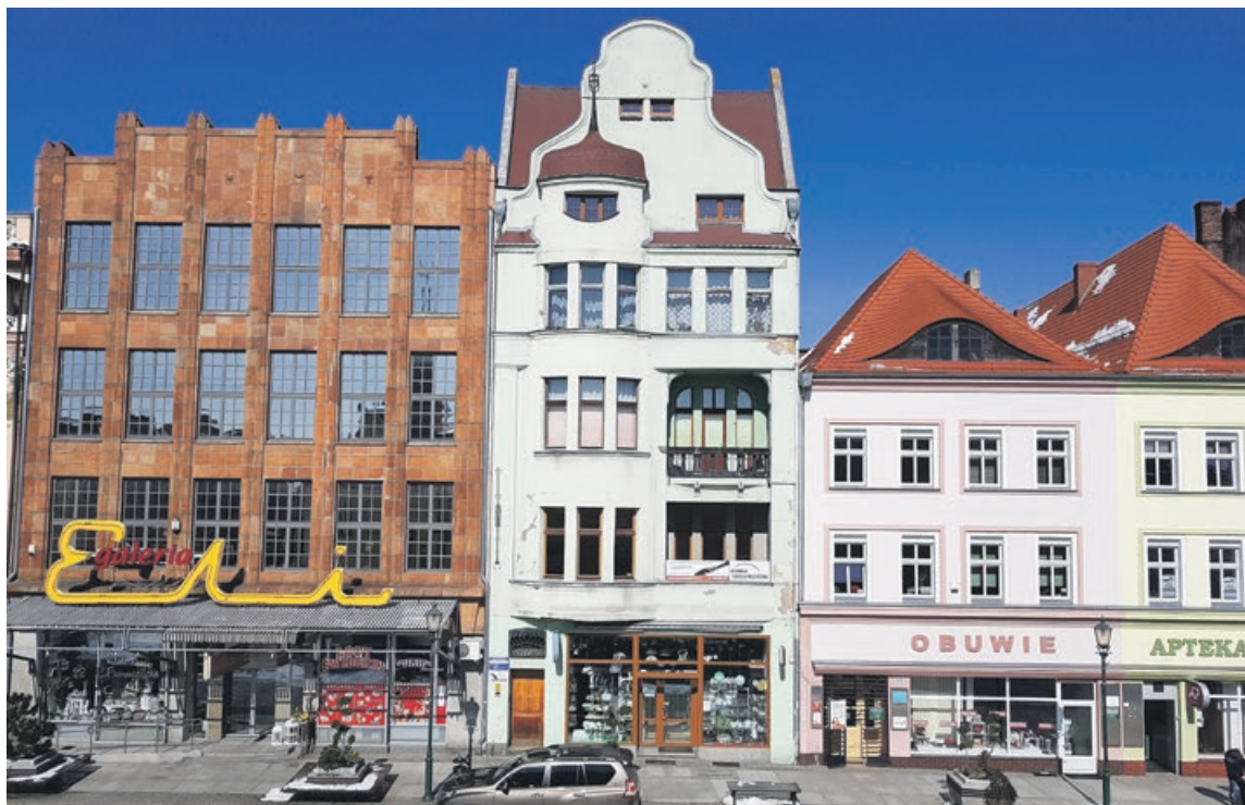
Jedna z kamienic zakwalifikowana do tegorocznej edycji jest ta, mieszcząca się przy pl. Rynek 10. Zostanie na niej wyremontowany dach oraz elewacja, która - jak widać gołym okiem, zaczyna się coraz bardziej sypać fot.Andrzej Buczyński
