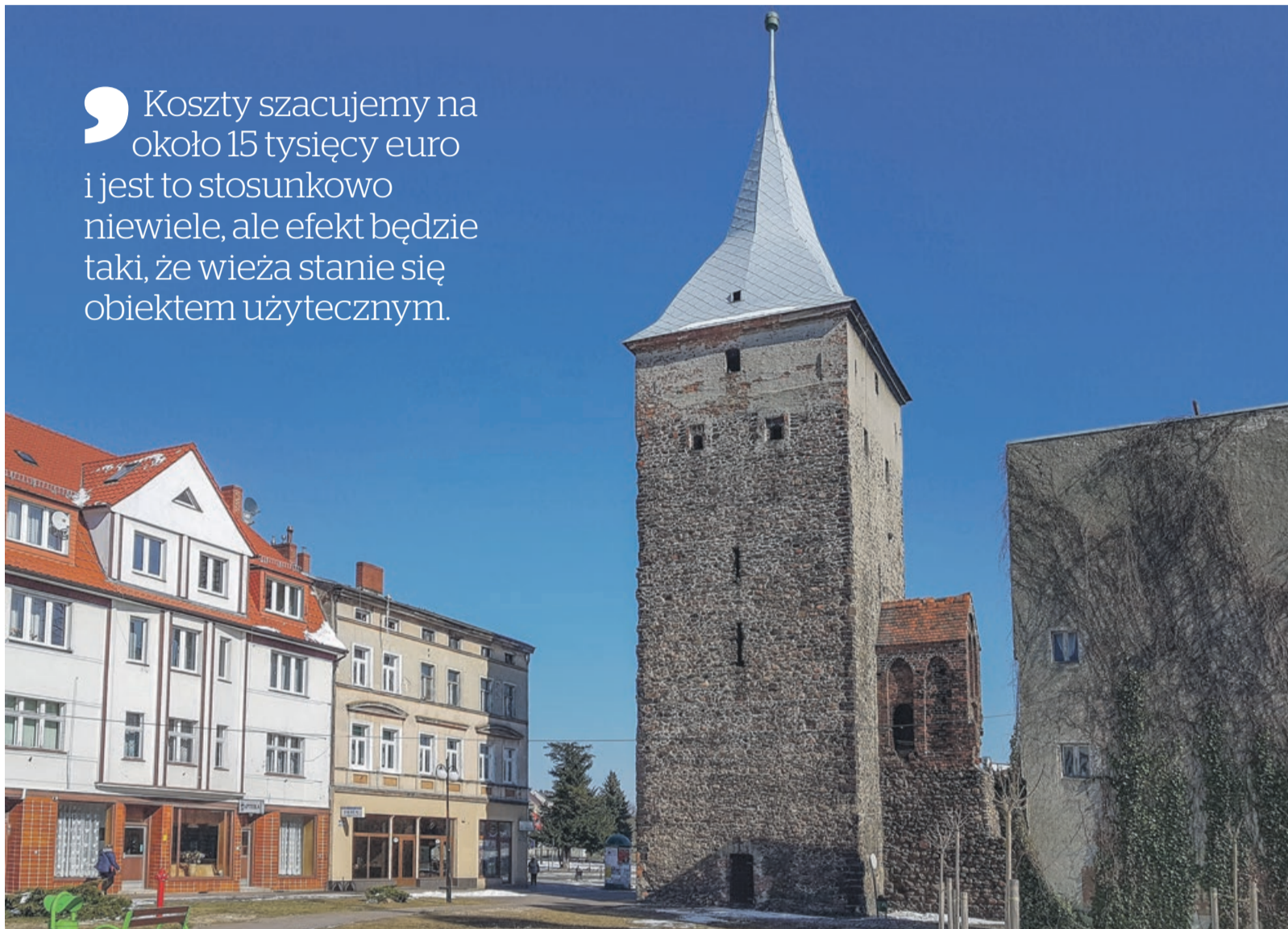
Po rozbiórce starej kamienicy wieża jest lepiej wyeksponowana fot. Andrzej Buczyński
