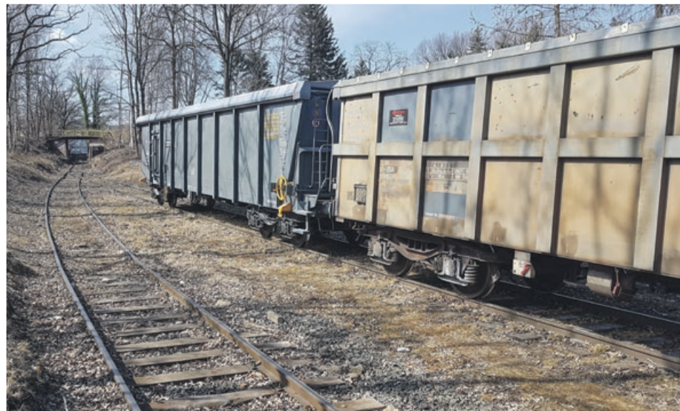
Tory biegnące do zakładu mają być częściej wykorzystywane fot. Andrzej Buczyński
