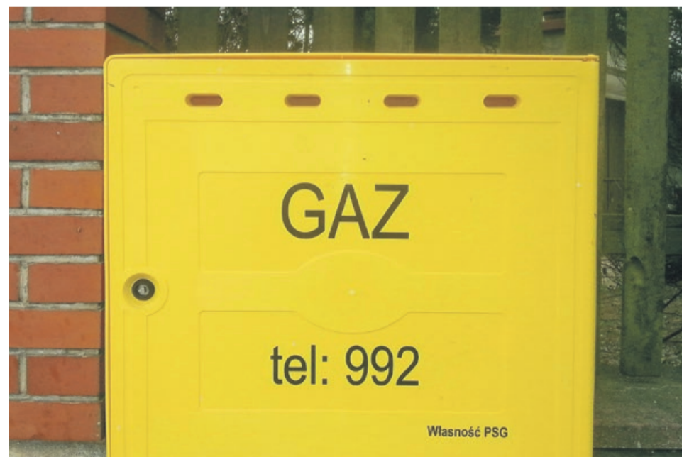
Właściciele gospodarstw domowych, przedsiębiorcy i inwestorzy nie powinni mieć problemów z dostawami i ciśnieniem gazu fot.Paweł Skrzypczyński
