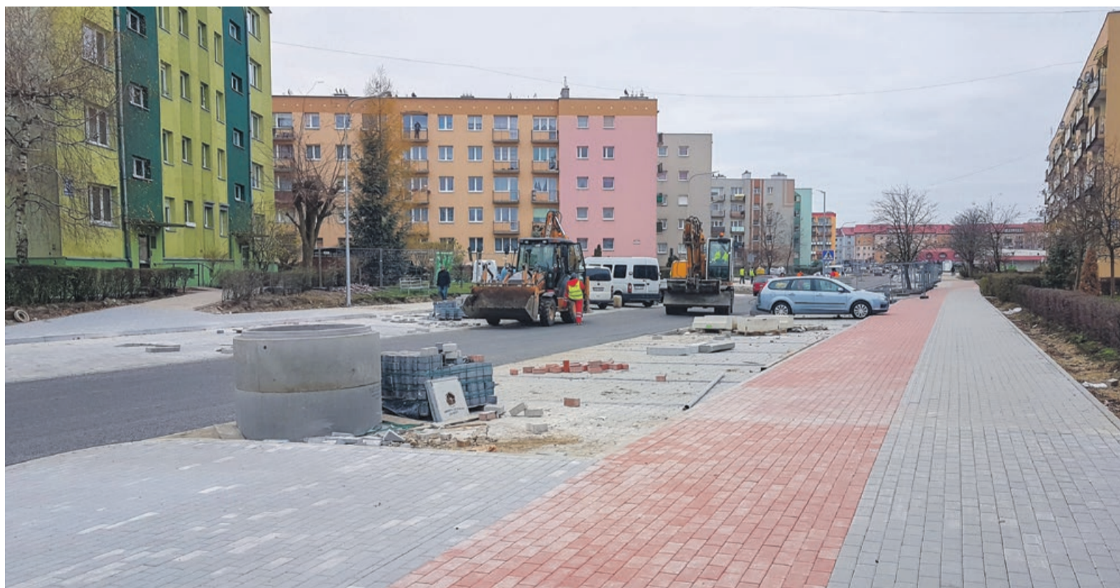
Do zakończenia pozostało naprawę niewiele fot. Andrzej Buczyński
