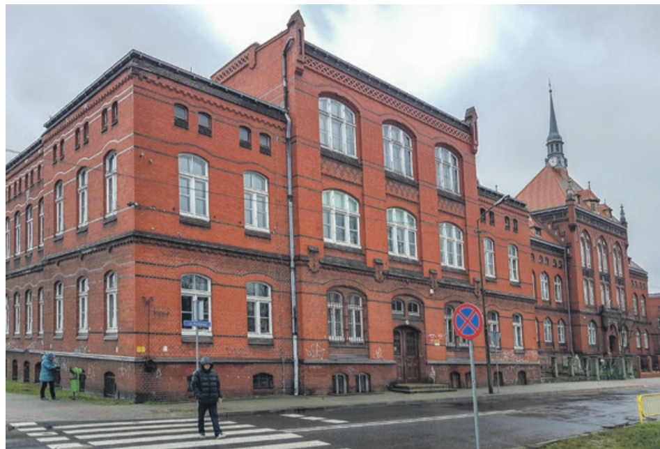
W Centrum Kształcenia Zawodowego i Ustawicznego w Żarach można jeszcze zaadoptować dodatkowe pomieszczenia fot. Andrzej Buczyński
