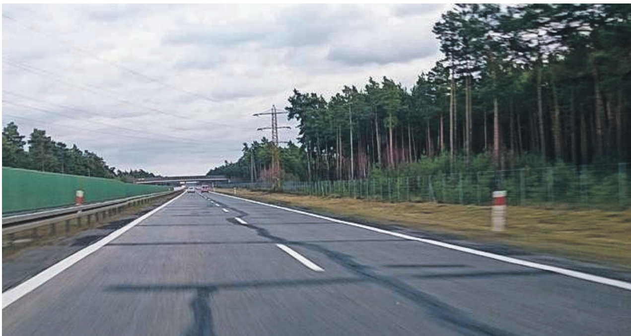
Przyszła autostrada usprawni komunikację i przyczyni się do rozwoju powiatu żarskiego oraz żagańskiego fot.ARMG
