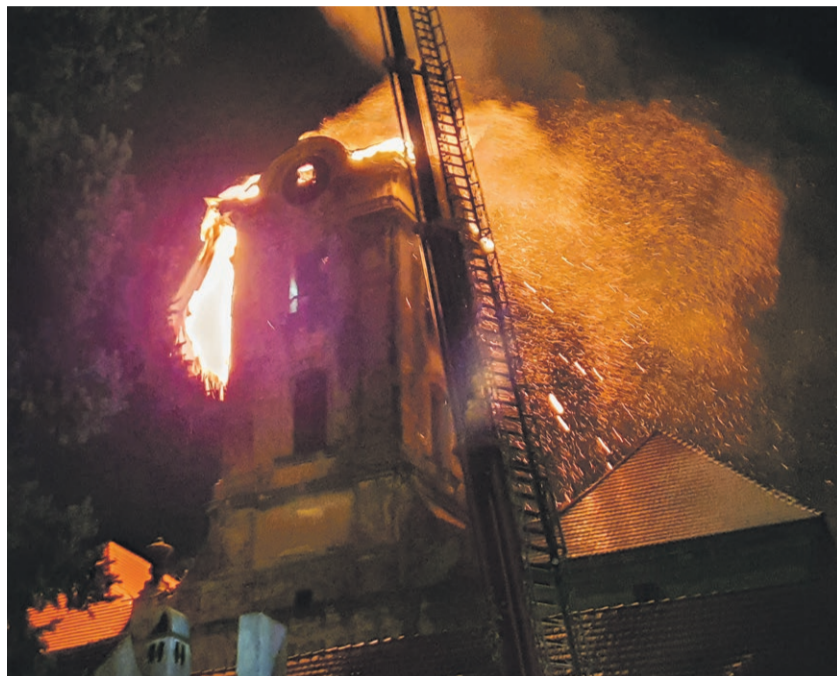
Hełm wieży runął na dach zachodniego skrzydła zamku fot. Andrzej Buczyński
