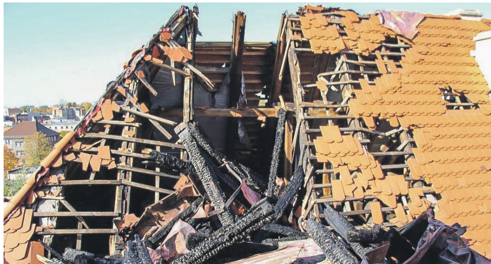
Uszkodzony dach zachodniego skrzydła zamku fot. UM Żary
