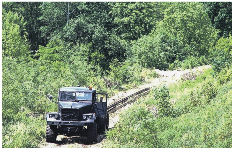
Demontaż linii kolejowej w Tuplicach w 2006 r. fot. Marek Szydłowicz
