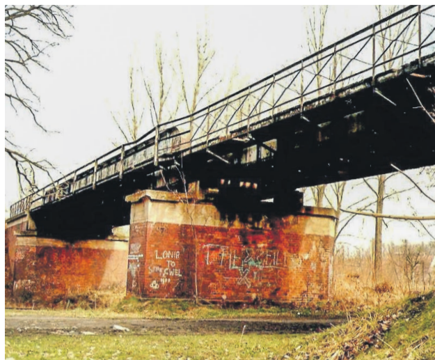
Najciekawszym obiektem inżynieryjnym na trasie jest silnie już zdewastowany wiadukt blachownicowy nad linią kolejową nr 14. Stan z 2001r. fot. Sławomir Fedorowicz
