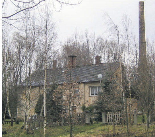
Jedyny ocalały obiekt po najstarszej zachodniej części cegielni Sommerfelder Ziegelwerke Freytag, Roll & Kreutz G.m.b.H. Budynek położony współcześnie przy ul. Transportowej 4, był od prawej strony przyłączony do części produkcyjnej zakładu fot. Grzegorz Dawczyk
