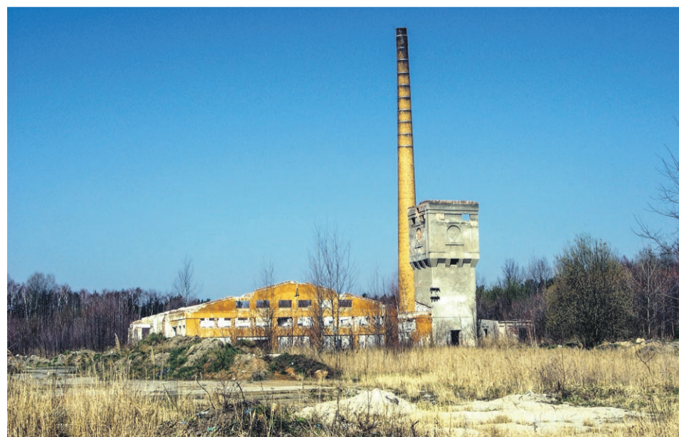
Budynek produkcyjny i kotłownia z charakterystycznym magazynem na trociny (2008 r.) fot. Grzegorz Dawczyk
