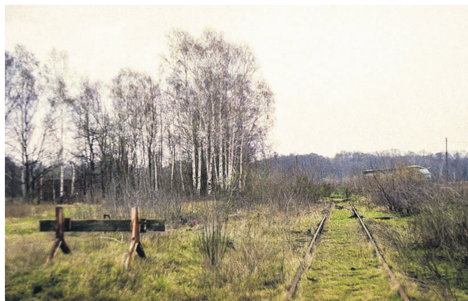
Rozjazd bocznic tartaku w Lesowie wraz z żebrem zabezpieczającym, w ostatnim okresie istnienia linii kolejowej Lubsko-Tuplice fot. Andrzej Klauza
