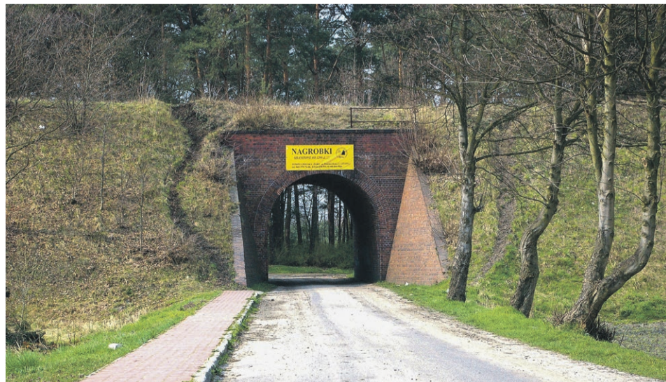
Sklepiony wiadukt, na którym linia kolejowa z Lubska do Tuplic przechodziła nad ul. Cmentarną fot. Grzegorz Dawczyk
