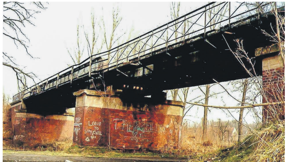
Stalowy wiadukt nad linią kolejową nr 14 (dalsze przęsło) w 2001r. Fotografia ta może być bazą porównawczą do dzisiejszego stanu technicznego obiektu fot. Sławomir Fedorowicz
