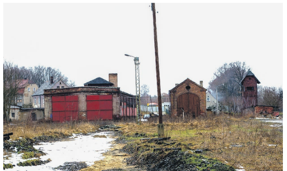
Od lewej: warsztat biura zabezpieczenia ruchu i łączności, warsztaty wagonowe, garaż dreźny ze stolarnią Rejonu Budynków, transformator i magazyn Rejonu Budynków (2008 r.) fot. Grzegorz Dawczyk
