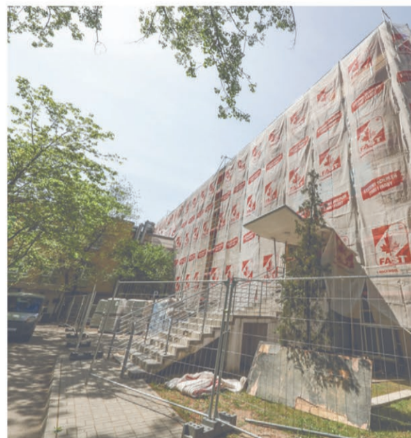
Termomodernizacja Szpitala Uniwersyteckiego w Zielonej Górze o wartości 50,3 mln zł
