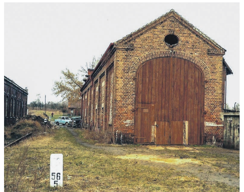
Garaż dreźny i warsztat Rejonu Budynków z wchodzącym doń żebrem 16a. Obok słupek pikietażu linii w kierunku Lubska i jej fragment zasypywany skarpią oporową. (2001r.) fot. Sławomir Fedorowicz
