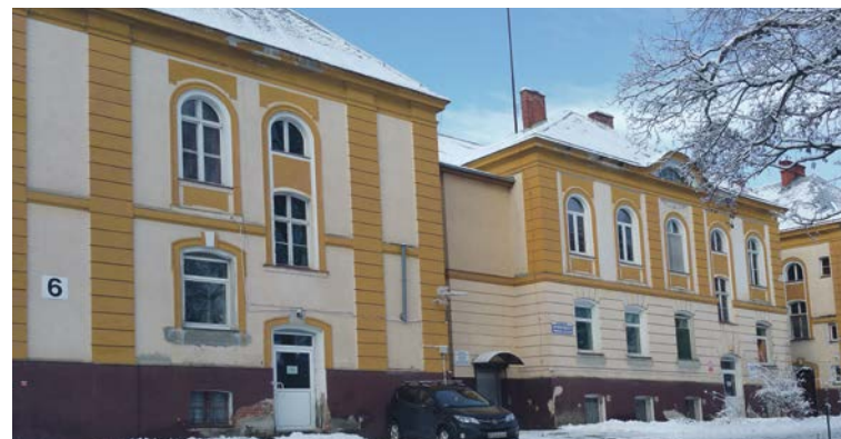
W budynku numer 6 są pomieszczenia, które można zaadaptować na oddział rehabilitacji fot. Andrzej Buczyński
