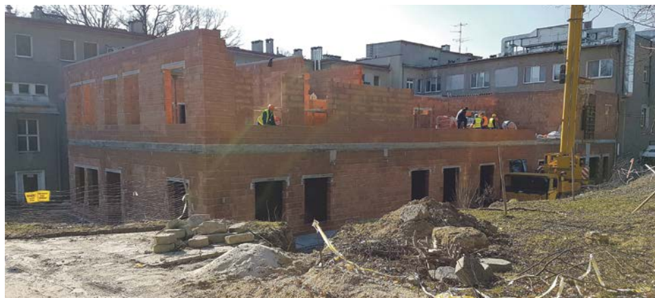
Trwają prace na terenie szpitala przy ul. Pszennej fot. Andrzej Buczyński
