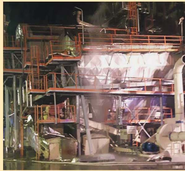
Na skutek ostatniego pożaru zniszczeniu uległa część linii produkcyjnej płyty OSB fot. KPPSP Żary
