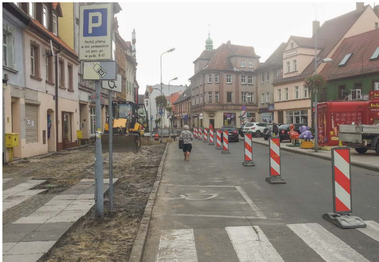
Remont chodnika już spowodował spadek ruchu w sklepach przy pl. Przyjaźni fot. Paweł Skrzypczyński
