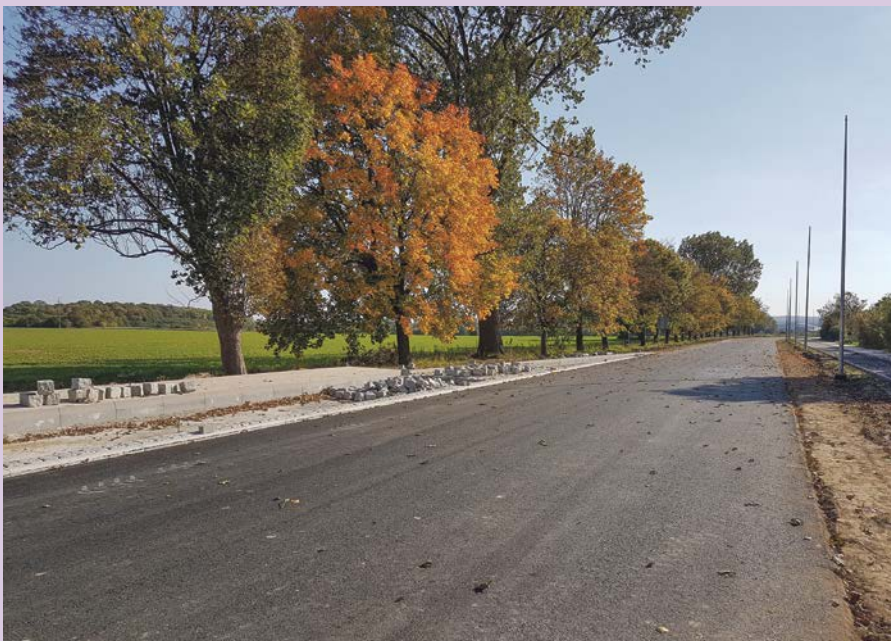
ŻARY Na części remontowanego odcinka ulicy Zielonogórskiej wylano już nowy asfalt. Układane są chodniki. Jednak na finał prac trzeba jeszcze poczekać fot. Andrzej Buczyński
