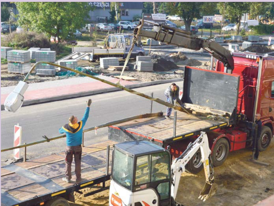
ŻARY Przy ul. Moniuszki budowlancy zdemontowali już stare lampy. Na remontowanej przez Starostwo Powiatowe ulicy zamontowane będzie nowe oświetlenie fot. Halina Gola
