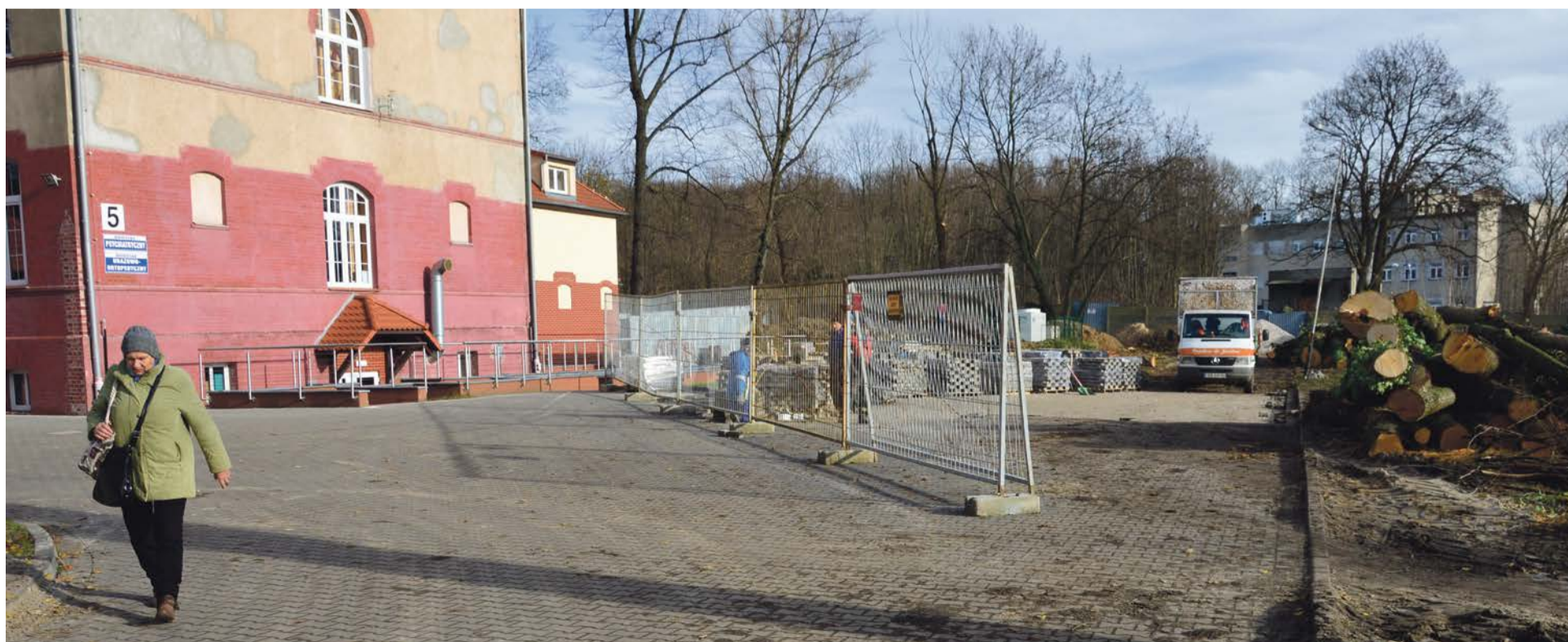
Nowy obiekt powstanie w tym miejscu. Prace już ruszyły. Trwa wycinka drzew i krzewów. Za płotem widać budynek Szpitala na Wyspie fot. Halina Gola
