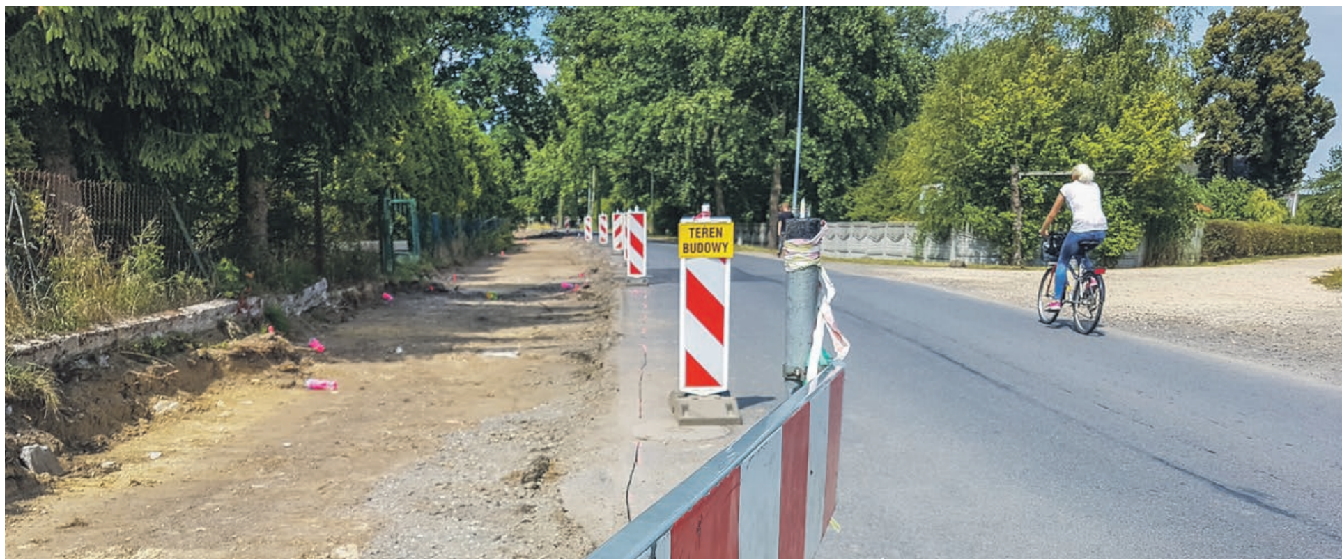
Prace przy al. Wojska Polskiego już się rozpoczęły fot. Andrzej Buczyński
