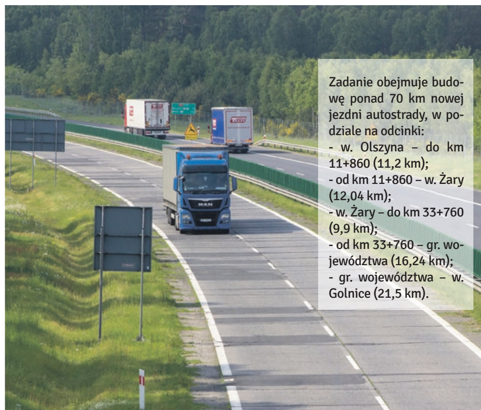
Południowa jezdnia A18 jest wybudowana z betonowych płyt w latach 30 ubiegłego wieku fot. Andrzej Buczyński
