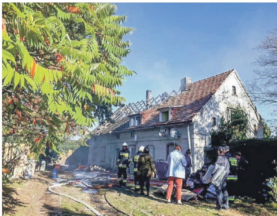
Pożar został szybko opanowany, ale dach wymaga remontu fot.KPSP Żary
