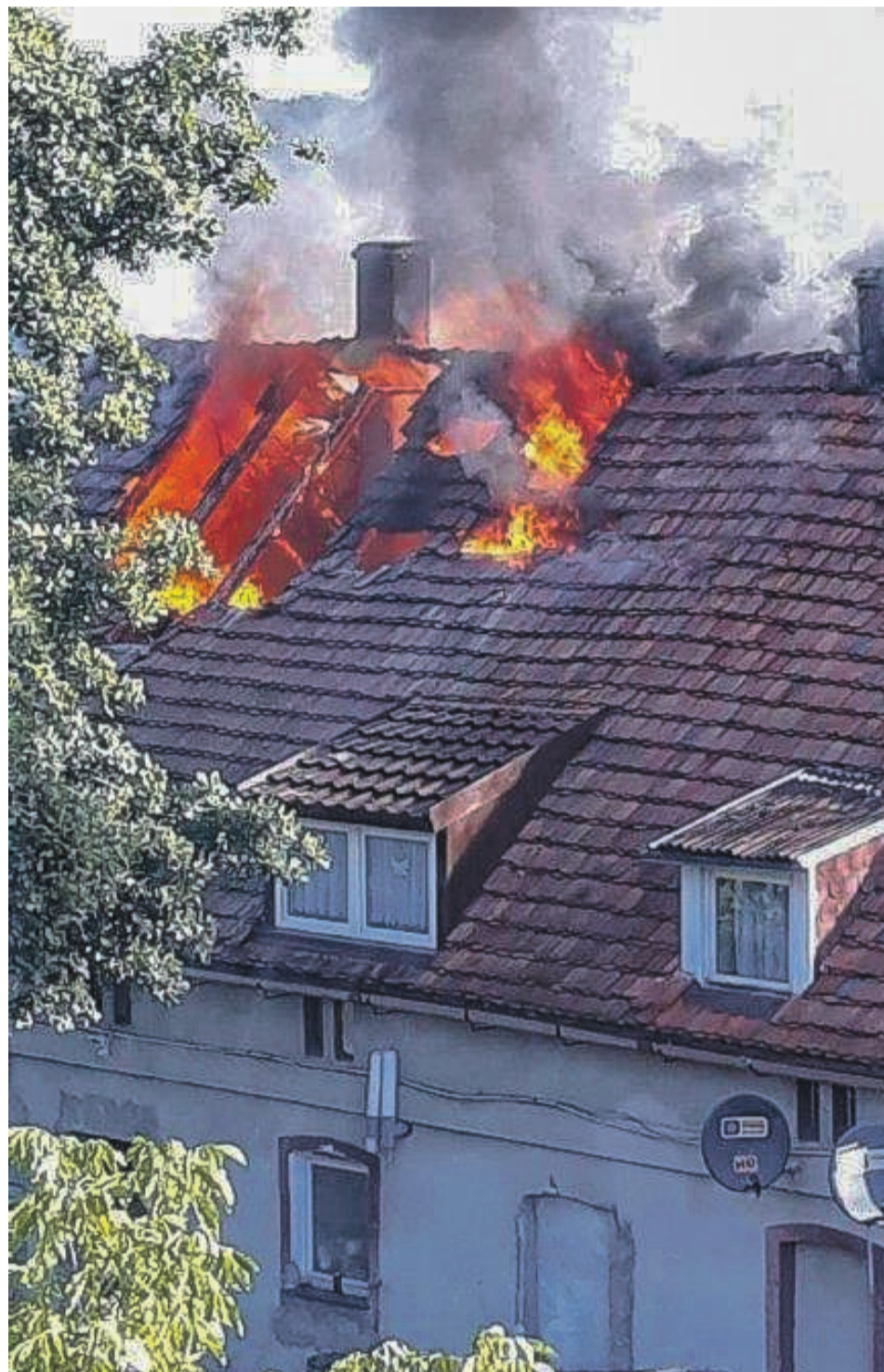
Ogień ogarnął dach budynku fot.KPSP Żary
