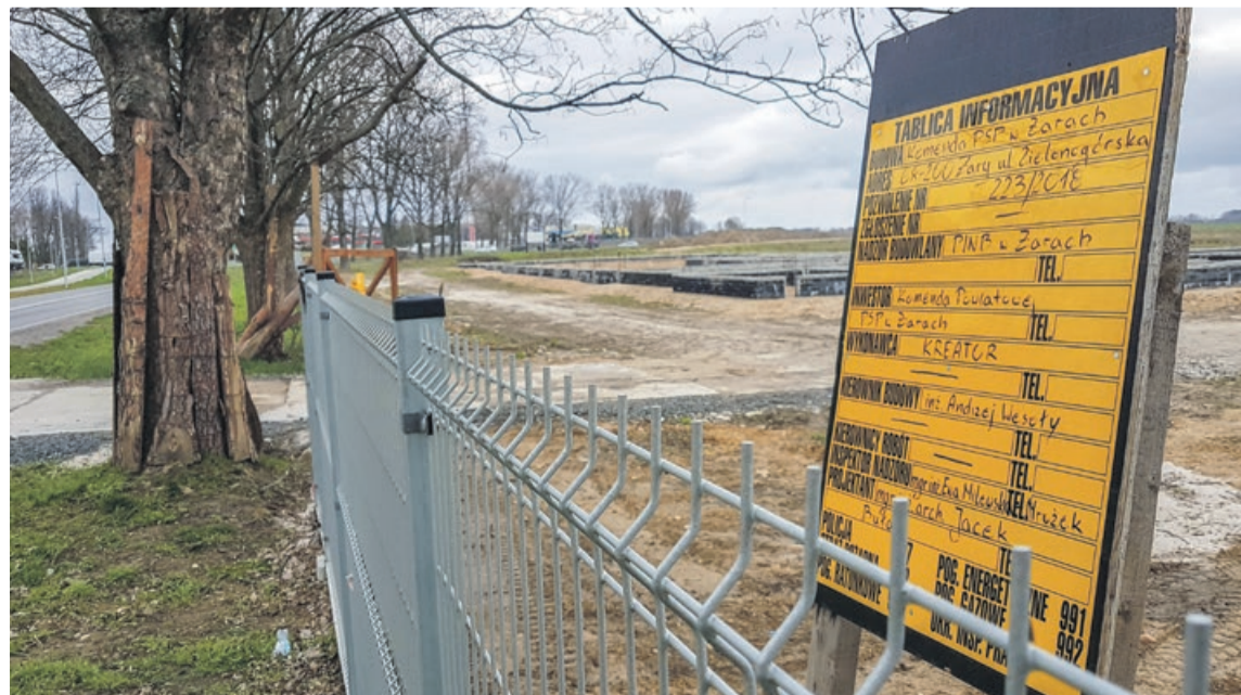
Przy ul. Zielonogórskiej w Żarach powstaje nowa siedziba straży pożarnej fot. Andrzej Buczyński
