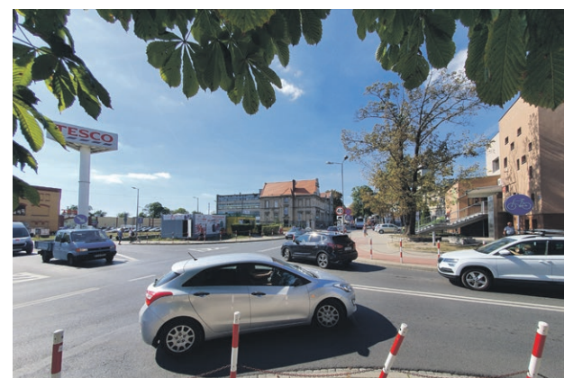
Skrzyżowanie do przebudowy fot. Andrzej Buczyński
