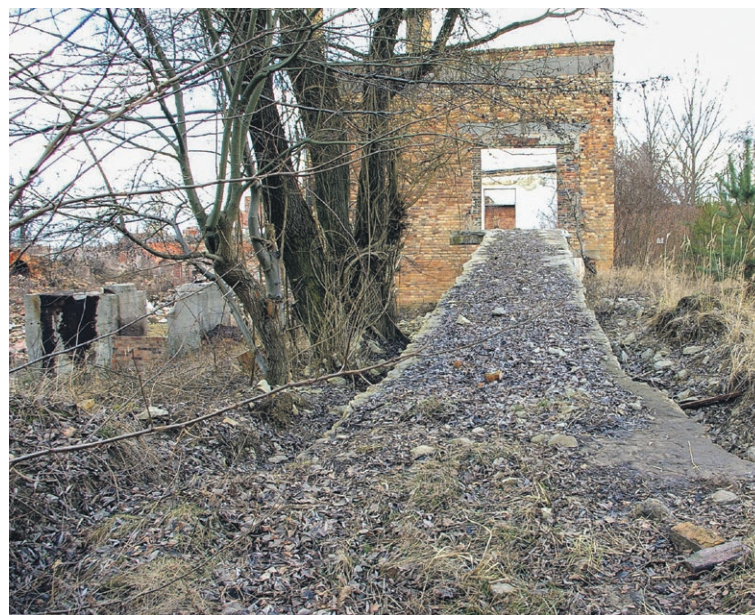
Pochylnia, po której wciągano wagoniki z urobkiem do budynku młyna i gniatacza (2009 r.) fot. G. Dawczyk
