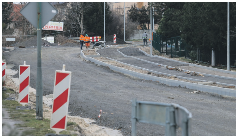
Przebudowa ul. Zielonogórskiej fot. Andrzej Buczyński
