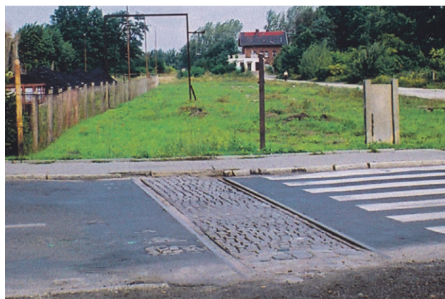
Fragment bocznicę do dawnych LZCB przy Głowackiego zachowany w ciągu ul. Kolejowej w 2006 r. Obok placu z opalem widoczna rama skrajnika; w oddali po prawej stronie budynek dworca bocznego fot. G. Dawczyk
