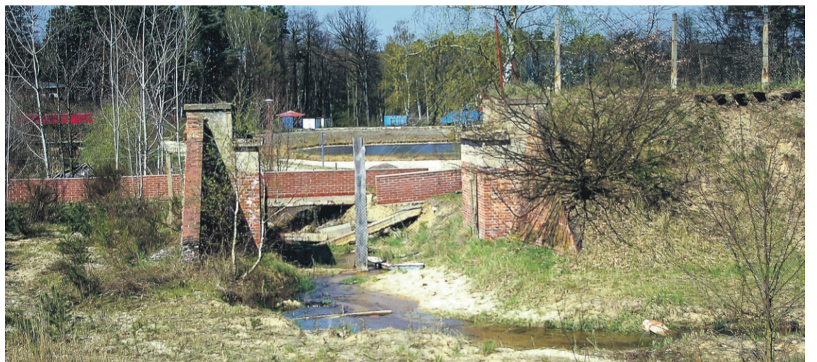
Postępująca degradacja obiektu (2008 r.) fot. Grzegorz Dawczyk
