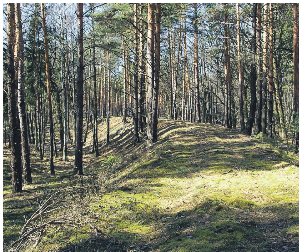
Jeden z bardziej spektakularnych nasypów kolejowych dawnej kolejki. W tym miejscu linia wąskotorówki prowadzącej z okolic Jeziora Głębokiego, łukiem przechodziła nad dolinką strumienia Jeziorna fot. Grzegorz Dawczyk
