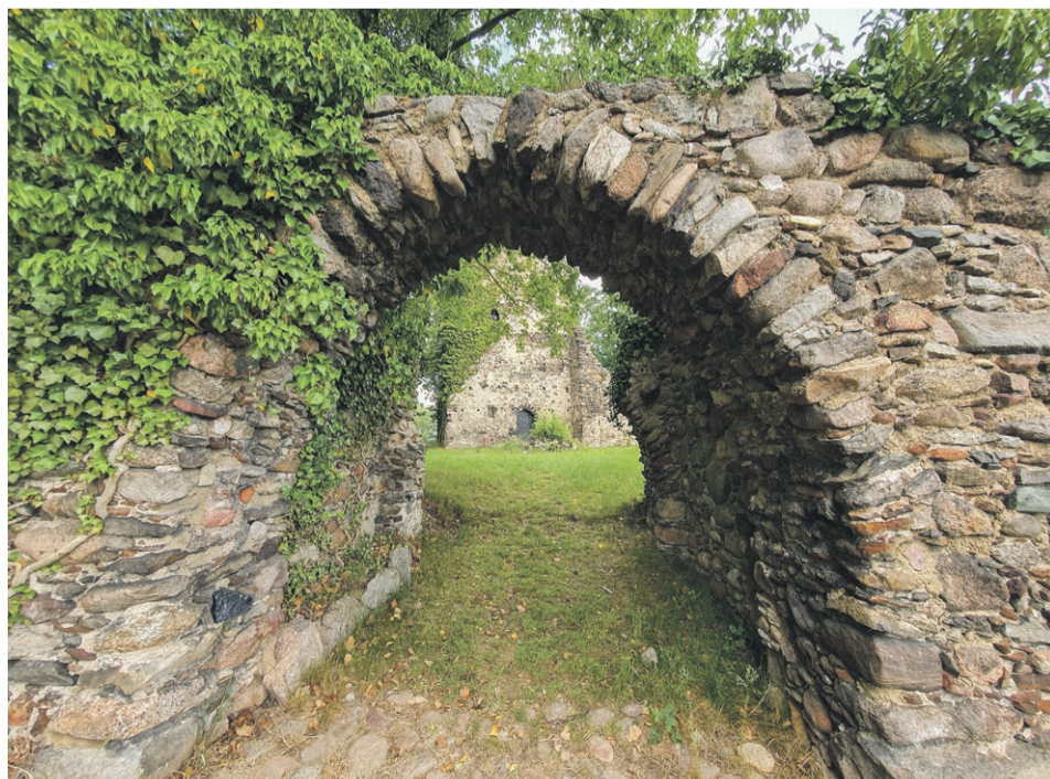
Uratowana przed zawaleniem brama z odkopanym brukiem fot. Andrzej Buczyński
