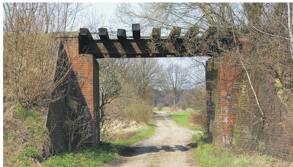
Blachownicowy wiadukt nad ul. Leśną w Tuplicach (dawniej Pförtenstraße) fot. Grzegorz Dawczyk
