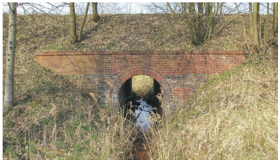
Sklepienie ceglane strumienia Jeziorna rozpoczyna sekwencję ciekawych obiektów inżynierskich w ciągu wału tuplickiego fot. Grzegorz Dawczyk
