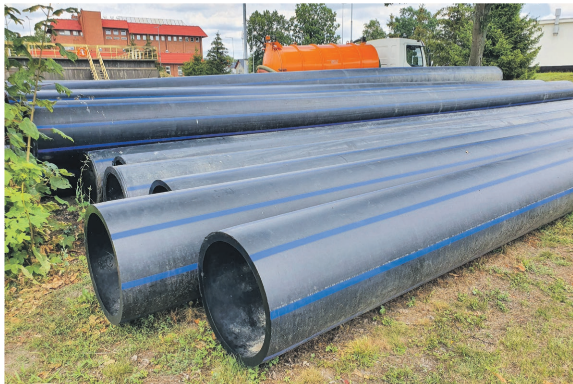
Rury z tworzywa PE o średnicy 560 mm - rurami o takim przekroju płynie woda ze stacji uzdatniania przy ul. Piastowskiej w kierunku Męczenników Ośw. fot. Andrzej Buczyński
