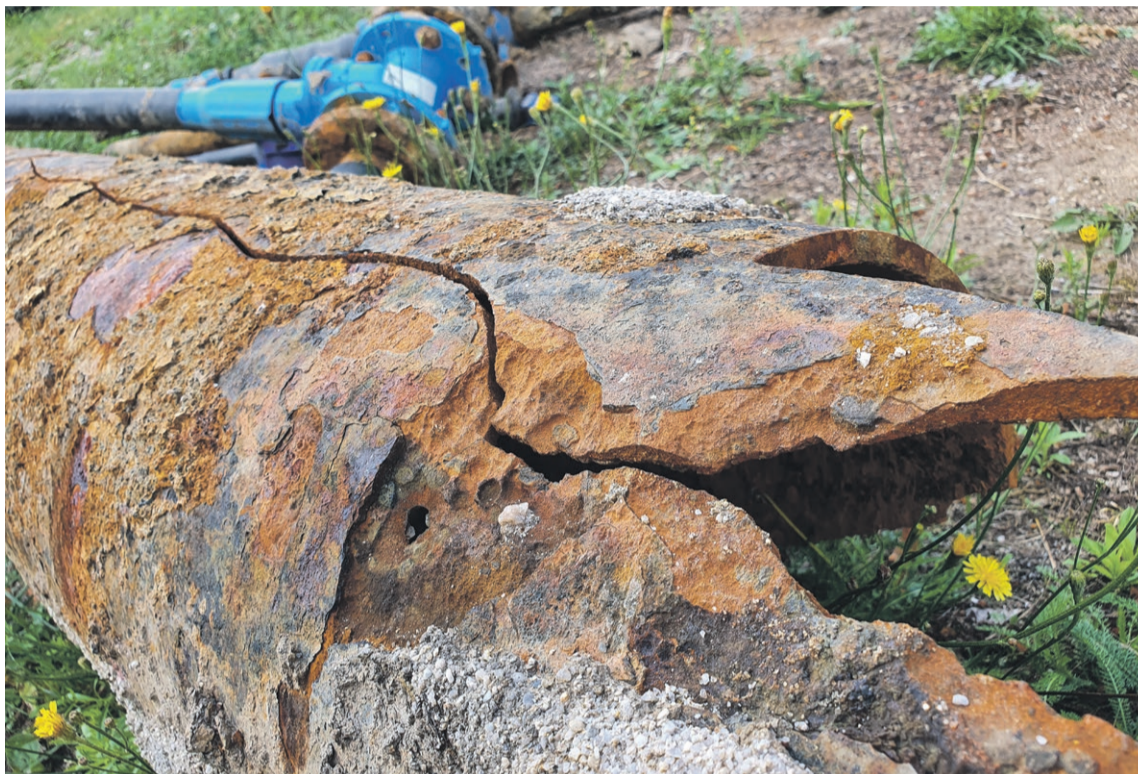
Pęknięta rura żeliwna z pl. Inwalidów fot. Andrzej Buczyński
