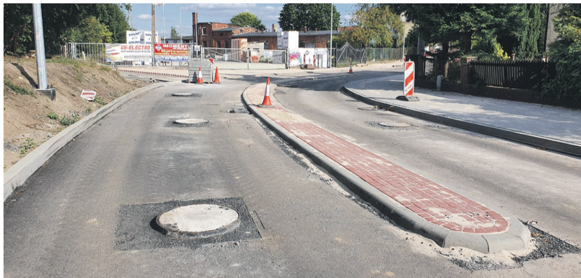
Taka wysepka ma spowolnić ruch na ul. Kujawskiej. Po położeniu ostatniej warstwy asfaltu będzie wystawać minimalnie fot. Andrzej Buczyński
