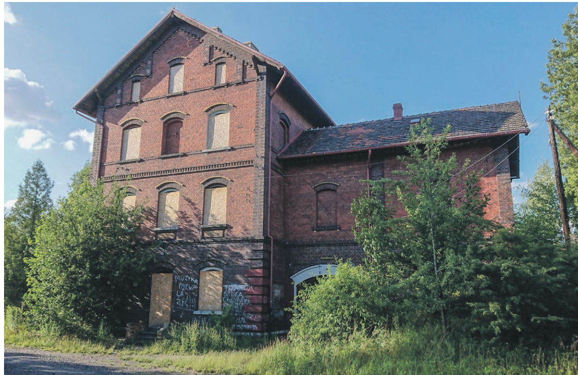
Współczesne ujęcie elewacji dworca od strony ul. Przemysłowej można zatytułować „krzaki i płyta OSB” fot. Grzegorz Dawczyk
