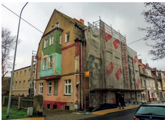
Wspólnota Mieszkaniowa przy ul. Żagańskiej 1 - dotacja 50.000 zł. Remont elewacji wraz z częściowym dociepleniem, remont dachu, remont klatki schodowej, wymiana stolarki okiennej i drzwiowej.
